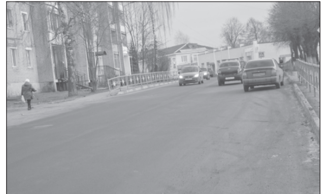
Так ровно и гладко выглядит трасса на ул. Революционной после капремонта
